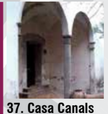
37. Casa Canals C. Ricard Canals, 5-7 Residència i taller del pintor Ricard Canals Llambi, projectada per l'arquitecte Duran i Reynals l'any 1929.
